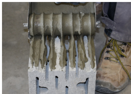
Encollage vertical sur les emboîtements en zone sismique 3
