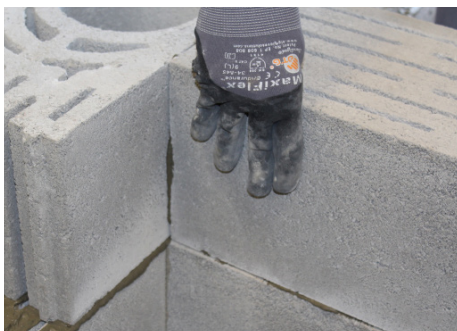
Encollage vertical sur les faces lisses (toutes zones)
