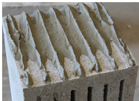
Encollage vertical sur les faces lisses (toutes zones)
