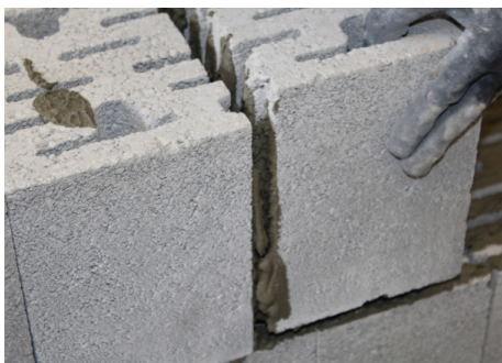
Encollage vertical sur les emboîtements en zone sismique 3
